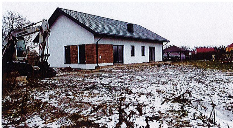
Światlica w Orkanowie - w trakcie budowy
