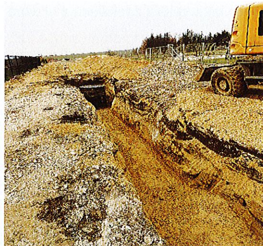
w trakcie inwestycji
