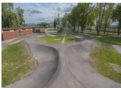
PUMPTRUCK - tor rowerowy asfaltowy
